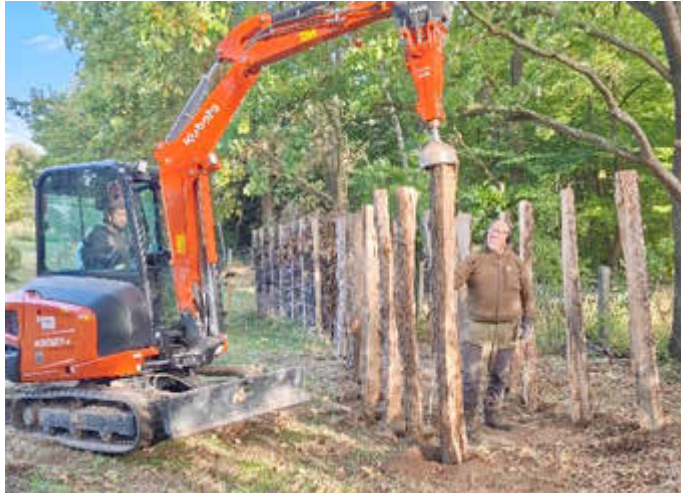
Einbau der Eichenpfähle der zweiten Benjes-Hecke.
