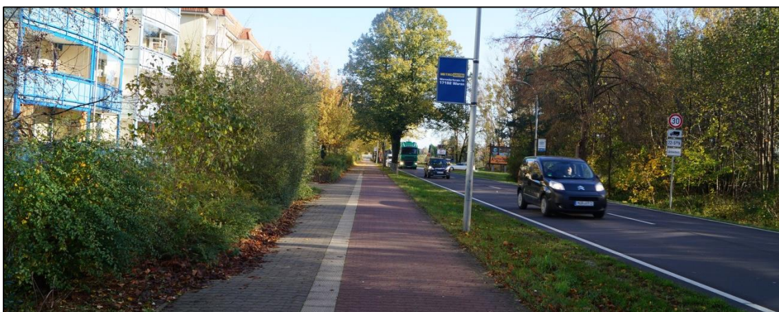
Abb. 31 Bestandssituation Seitenraum Rübeler Chaussee
