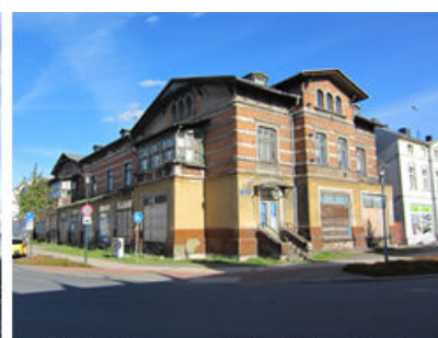
Bahnhofstr. 20 (erhebl. Schäden)
