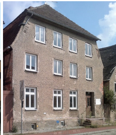
Große Burgstraße 9 (erhebliche Schäden)
