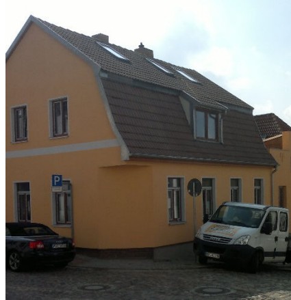
Hafenstraße 13 (voll saniert)
