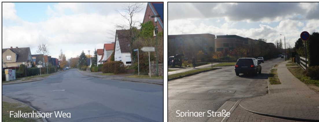
Abb. 7 Oberflächendefizite im Ergänzungsstraßennetz
