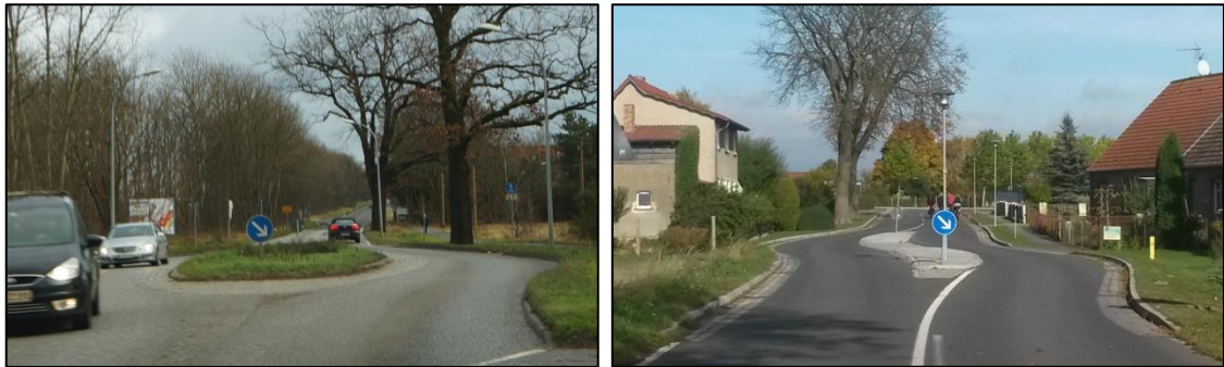
Abb. 30 Beispiele Ortseingangsgestaltung mit Fahrstreifenversatz
