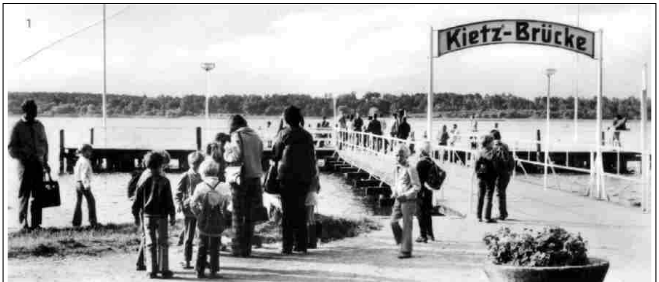
Kietzbrücke um 1975, damals noch als Holzkonstruktion (Quelle: www.waren-an-der-mueritz.de )
