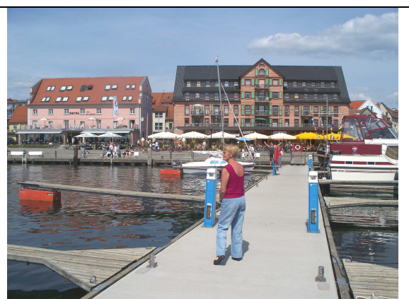
Sanierte Speichergebäude mit Gastronomienutzung am heutigen Stadthafen (Foto: plan4)
