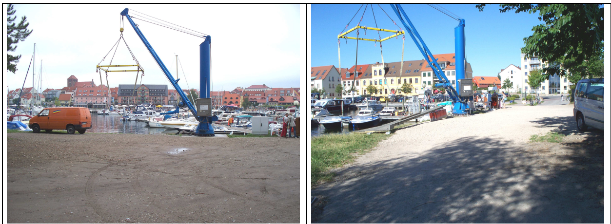
Stationärer Säulenkran (6,4 t) am Südkai des Stadthafens für Boote bis 10 m Länge (Fotos: plan4)
