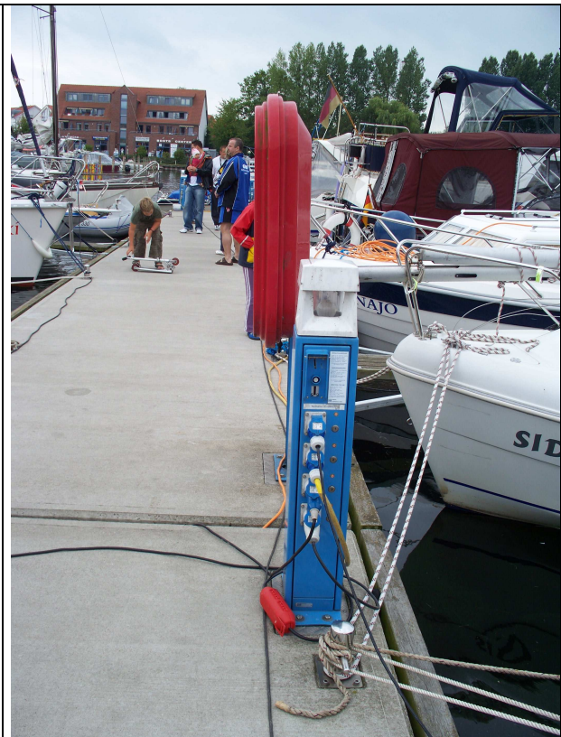
Stromsäule am Steg A1 (Fotos: plan4)
