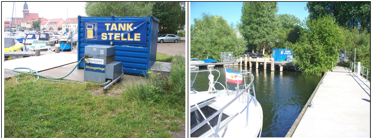
Wassertankstelle und Fäkalienabsauganlage am Südufer des Stadthafens (Fotos: plan4)
