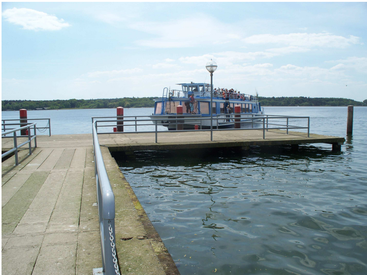
Anlegestelle für die Fahrgastschifffahrt an der Kietzbrücke (Foto: plan4)
