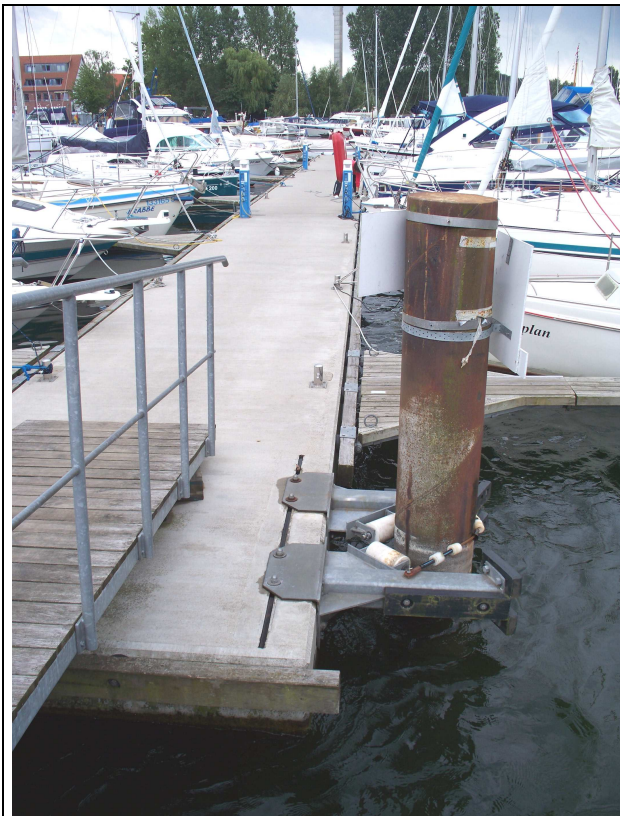
Verankerung mit Dalben am Steg A1
