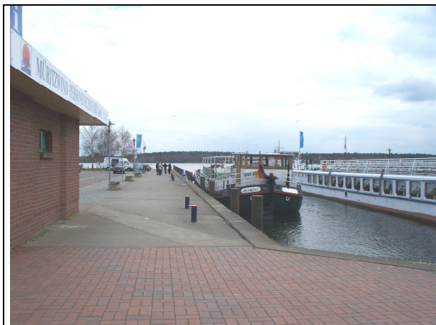
Steinmole mit Pavillon der Müritz-Wind GmbH
