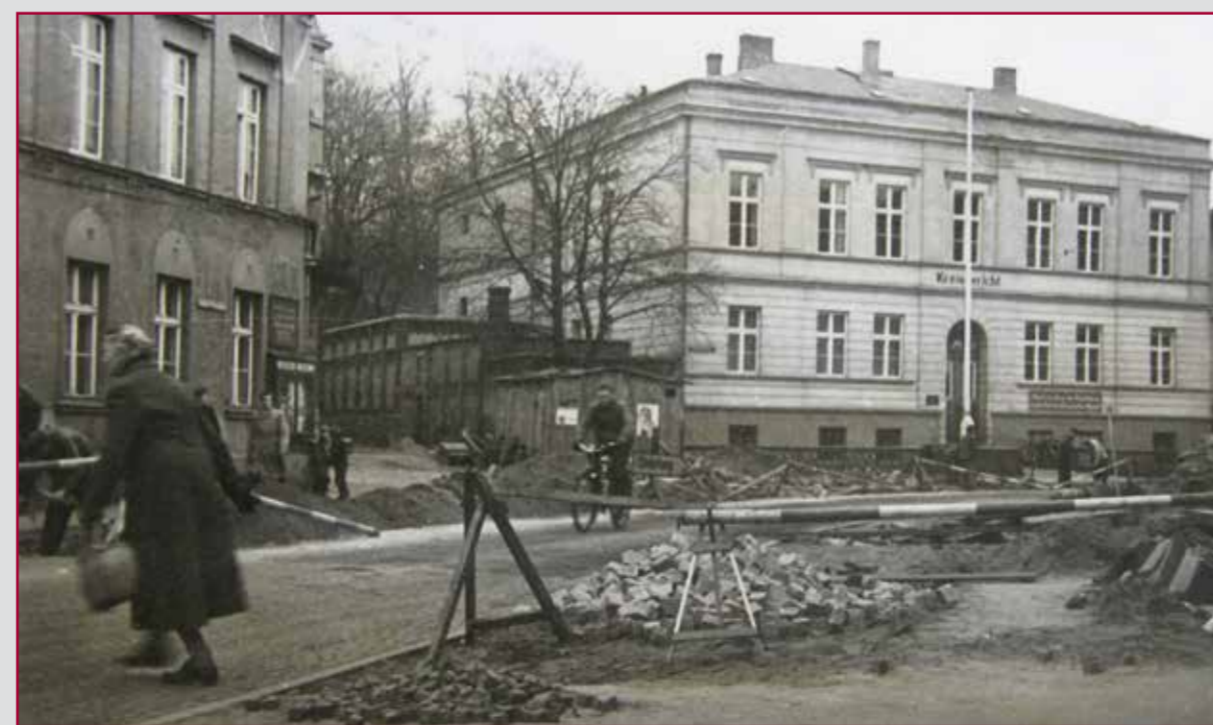
Blick auf das Gerichtsgebäude um 1958
