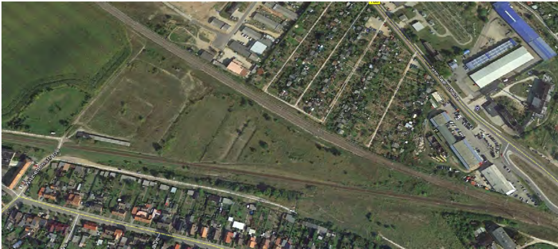
Abbildung 12: Luftbild des 2014 bis auf den Garagenkomplex im Südwesten entsiegelten Abschnitts der Vorhabenfläche. Quelle Google Earth 2016.
