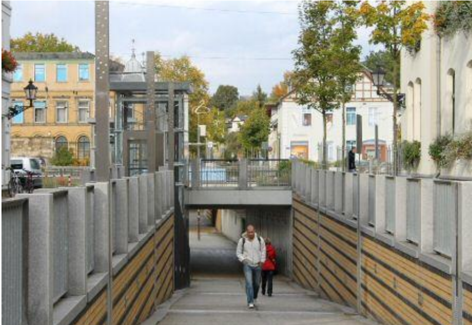
Abbildung 15: Tunnel in Waren (Müritz) (Quelle: /19/)
