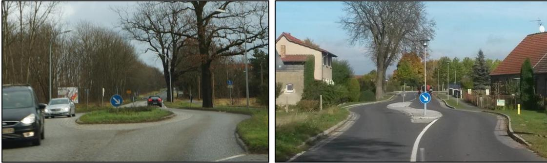
Abb. 32 Beispiele Ortseingangsgestaltung mit Fahrstreifenversatz
