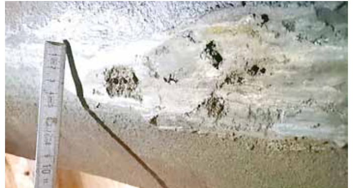
Das Foto zeigt: das Material der Glocke ist porös.
