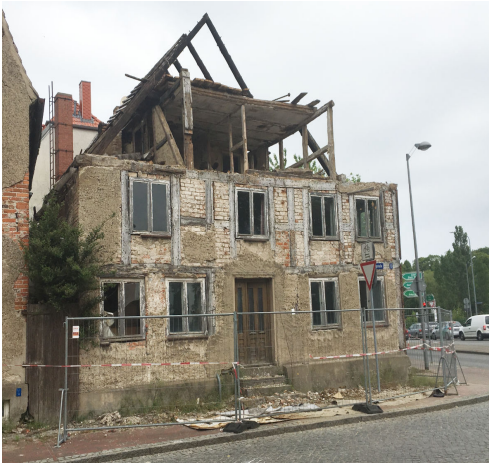
Große Burgstraße 10 (vor dem Abriss)
