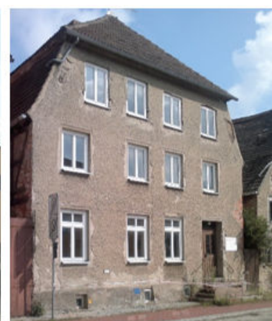
Große Burgstraße 9 (erhebliche Schäden)
