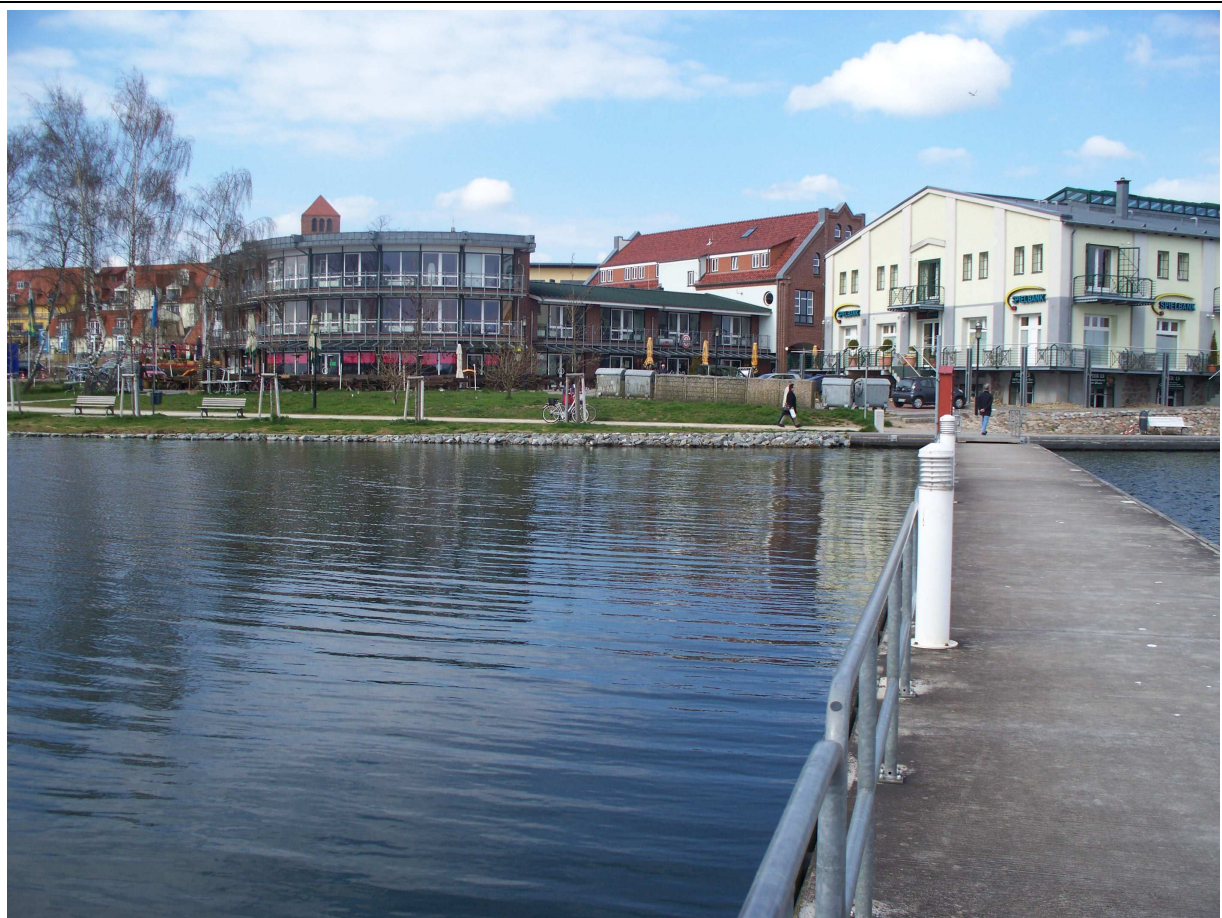
Uferbereich südlich der Gebäude Strandstraße 3 und 4 - geplantes Areal für den erweiterten Fahrgasthafen mit Neubau einer „Eckmole“ (Variante 2)
