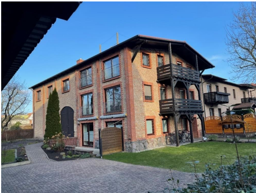
Angrenzende Nachbarbebauung Papenbergstraße 43a ausgebautes ehemaliges Bauerngehöft in 3-Geschossiger Bauweise
