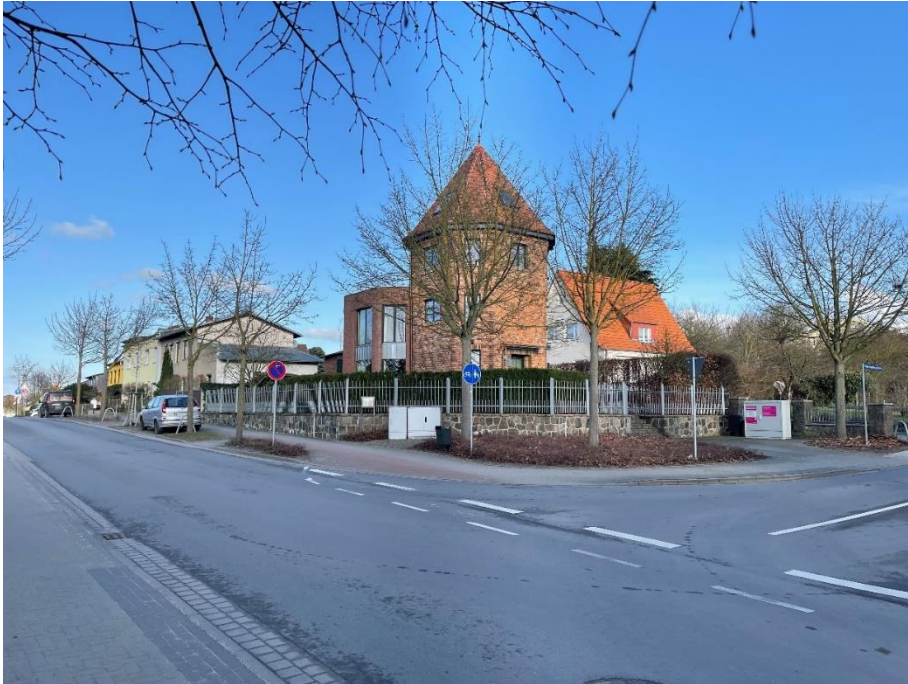
Papenbergstraße 30 a Baudenkmal ehemalige Transformatorenstation, Einmündungsbereich Rosa-Luxemburg-Straße
